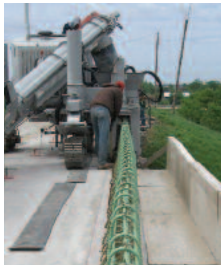
Pouring barrier over rebar cage.
